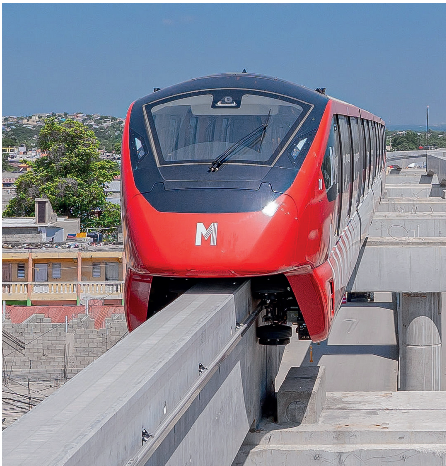
El Monorriel de Santiago es una de las principales obras viales de la gestión.
